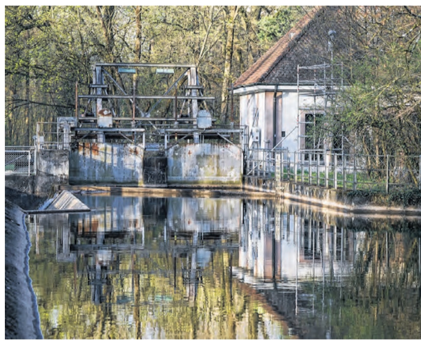
Das 100-jährige Wasserkraftwerk Riehenteich in den Langen Erlen kann besichtigt werden.
