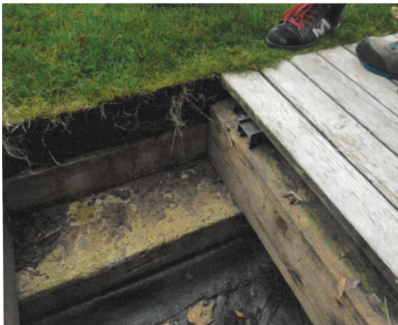
Gehfläche mit Tragebalken
