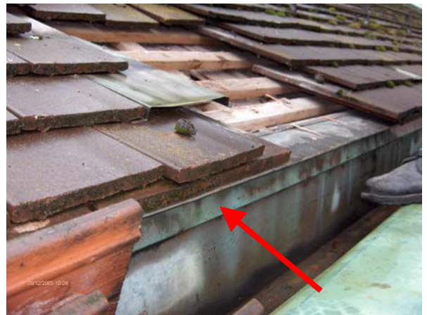
Ein- bzw. Austrittsöffnung sind unzureichend ausgebildet oder teilweise nicht vorhanden.
