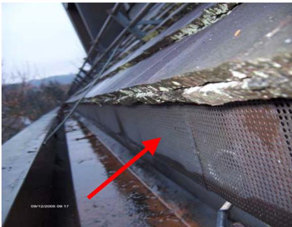
Ein- bzw. Austrittsöffnung sind unzureichend ausgebildet oder teilweise nicht vorhanden.
