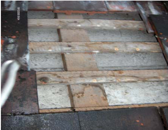
Angefaltete Unterkonstruktion als Folge der unzureichenden Dachhinterlüftung
