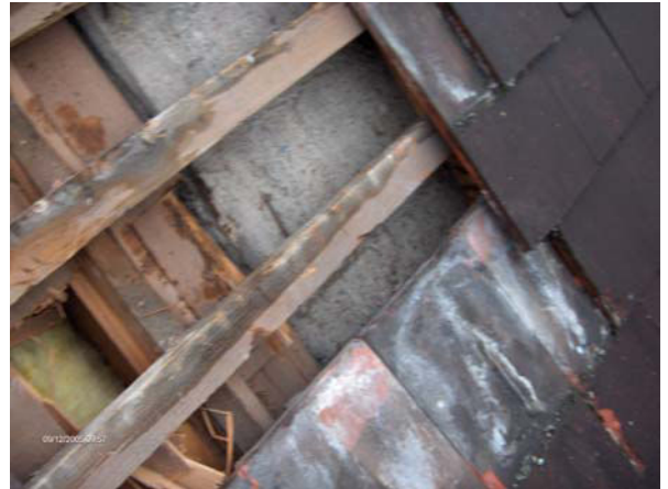
Angefaltete Unterkonstruktion als Folge der unzureichenden Dachhinterlüftung
