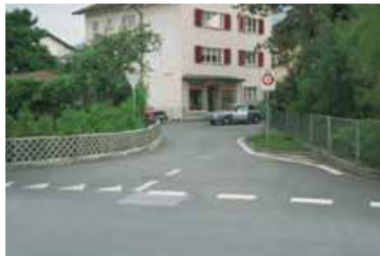
Torelement zu Beginn der Tempo-30-Zone
