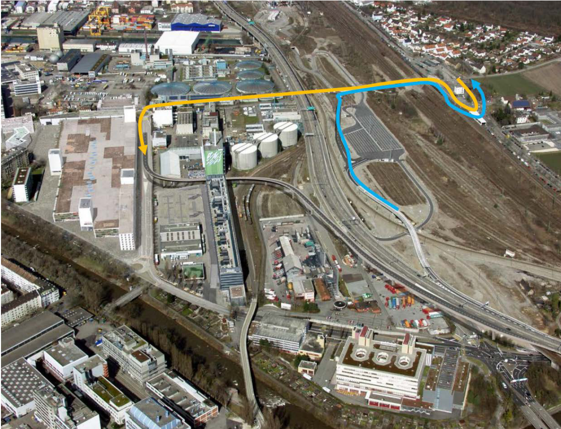
Autobahnrampen Neuhausstrasse: Auffahrt Richtung Schweiz (gelb) und Abfahrt Richtung Zollfreie Strasse (blau).
